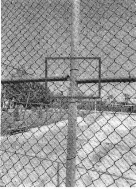
KAYNATILACAK (KUZEY CEPHE POTA YANI)
